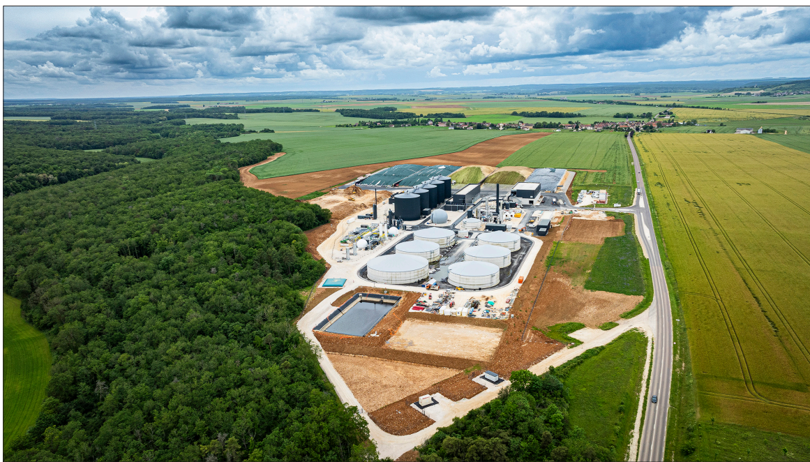
Photo de gauche : Vue aérienne du méthaniseur de Cérilly. L'équipement s'étend sur 15 ha et comprend, outre les cinq unités de méthanisation, quatre silos de stockage des Cives collectées chez les agriculteurs, qui peuvent aussi les acheminer sur site, ce qui influe sur le prix payé à la tonne. Crédit : Alliance BFC. Photo de droite : Thomas Lorin (à gauche), directeur de l'unité Sécalia. Laurent Druot (à droite), responsable de l'équipe développement énergies renouvelables dans le groupe Dijon Céréales. Crédit : JDP.
