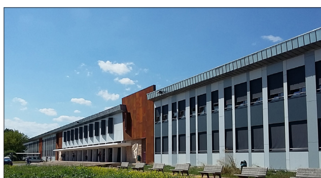
2,5 M€ d'aides sont alloués à la mise en accessibilité du lycée René Cassin à Mâcon. Crédit : CALC Architecte
