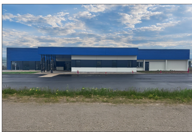
Livré nu, le bâtiment de 2.000 m2 devra être aménagé par la suite. Crédit : Délisens.
