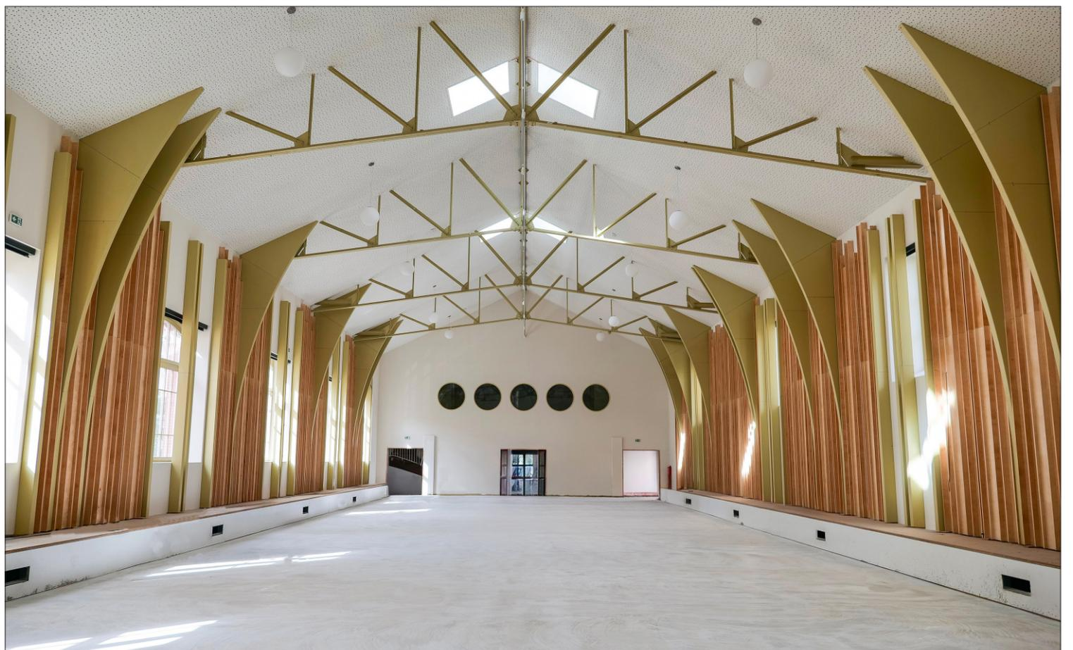
La suppression du plancher des combles et l'apposition de matériaux acoustiques performants proposent, à présent, une nouvelle perspective architecturale sur la charpente métallique qui n'avait jamais été mise au jour auparavant. Crédit : Ville d'Auxerre.
