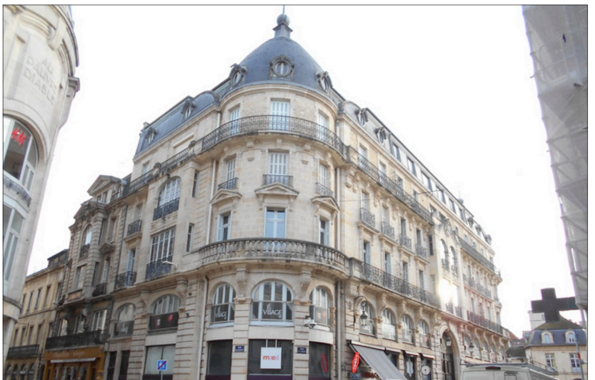
Le site des Godrans, à l'angle de la rue des Godrans et de la rue de la Liberté à Dijon. Crédit : Dijon Métropole / D3B.
