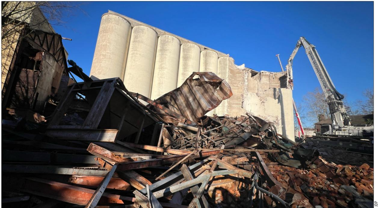
Au rythme d'une cellule par jour ou presque, les mâchoires de la plus grande pelle mécanique d'Europe - 76 mètres de haut pour plus de 300 tonnes à la pesée - déployée par la
