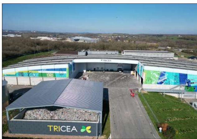
Réalisé et exploité par l'entreprise côte-d'orientale E3R, le centre de tri Tricea traitera 12 matières différentes, du carton au plastique en passant par l'aluminium ou l'acier. Crédit : Smet 71.
