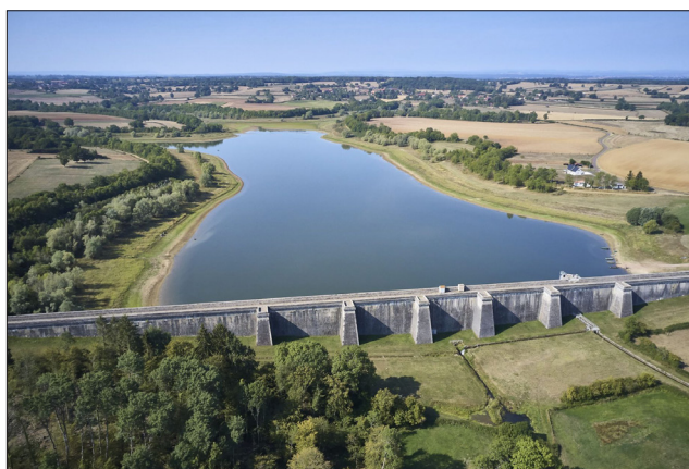
Le barrage réservoir de Chazilly fait partie des six barrages qui alimentent le canal de Bourgogne. Crédit : VNF Damien-Lachas
