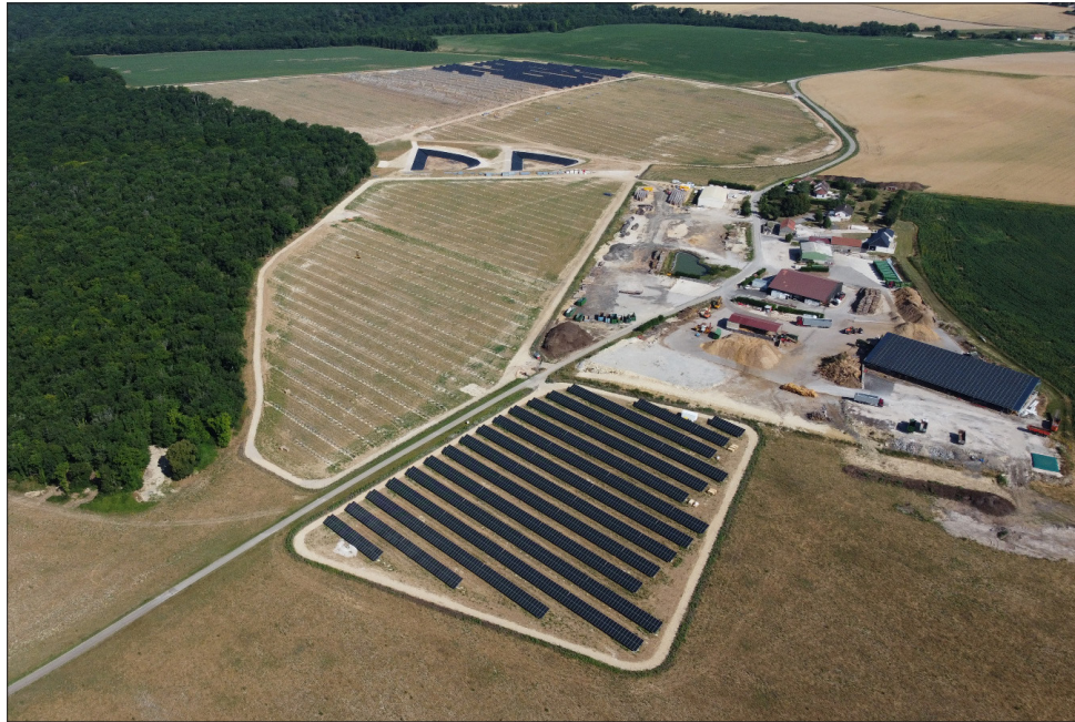
L'entreprise de transformation de bois en biomasse bois énergie est incluse au sein de parcs photovoltaïques et portait également un projet d'hydrogène vert. Crédit : RCKSC.
