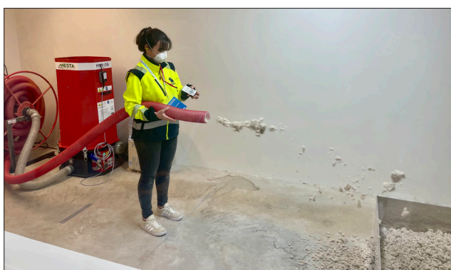
La ouate de cellulose Cristal résulte d'une fabrication par broyage puis d'adjonction d'additifs de la glassine qui pour être collectée doit contenir moins de 15% d'humidité. Elle est ensuite décompactée sur les chantiers puis projetée ou utilisée dans les alvéoles des cloisons des bâtiments à ossatures bois. Crédit JDP.
