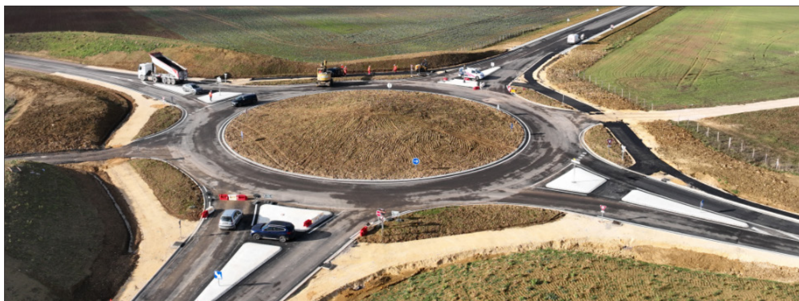
La première section de la Liaison sud d'Auxerre (Lisa) sous sa maîtrise d'ouvrage du conseil départemental de l'Yonne intègre l'implantation d'un giratoire à Chevannes. Crédit : CD89.
