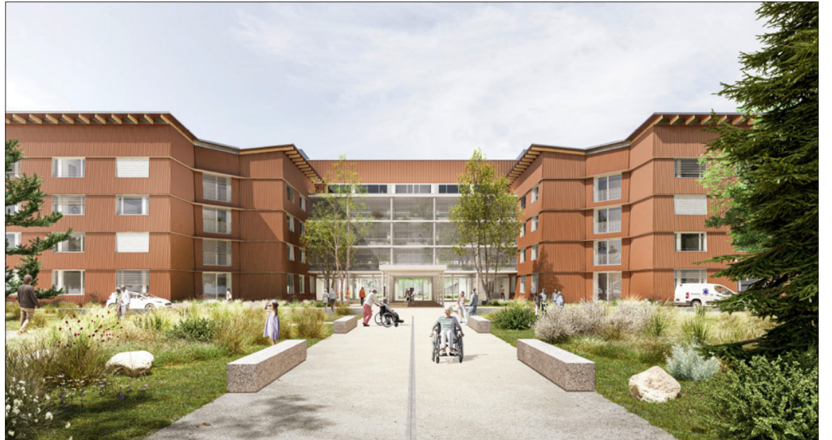
D'une dimension hors norme de près de 20.000 m 2 , la future Maison départementale de retraite de l'Yonne (MDRY) pilotera l'ensemble de la politique de services médico-sociaux de la collectivité. Crédit : Tectoniques Architecture.
