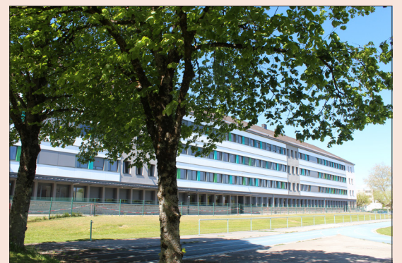
La rénovation de l'internat du lycée Pergaud à Besançon (14 M€) a été inaugurée mardi 21 avril. Crédit : JDP.
