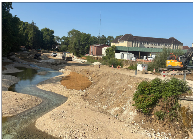
Le chantier du moulin Lemoine se poursuit à Chatillon-sur-Seine pour créer un jardin destiné à accueillir les eaux de pluie biennales afin de mieux anticiper les inondations. Crédit : CC du Chatillonnais.
