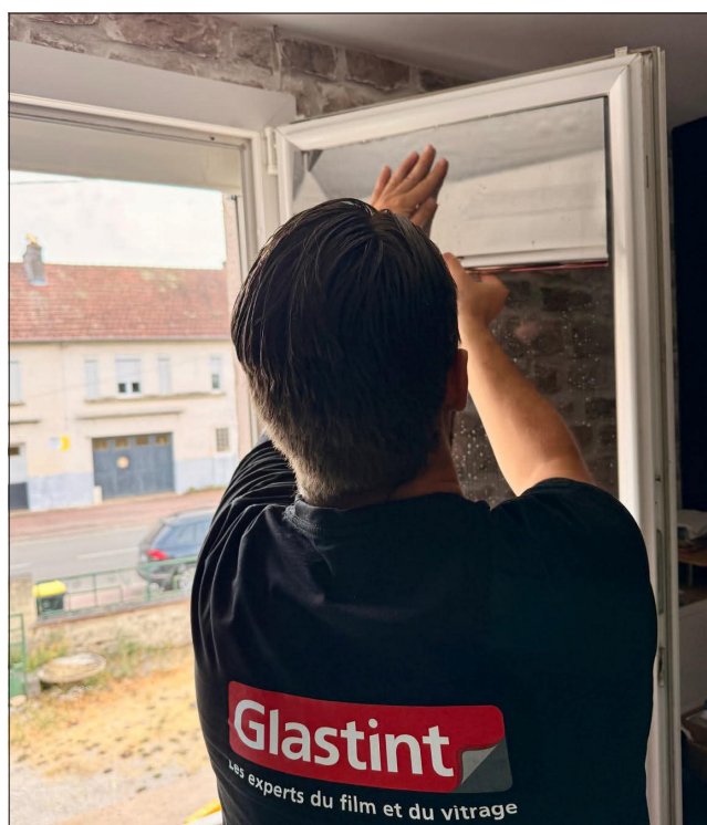
Certains films intègrent notamment des couches métalliques, avec différents niveaux de réflexion et de teinte. Crédit : Glastint.
