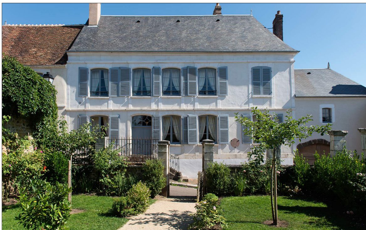
En état de délabrement avancé lors de son rachat par l'association, la Maison de Colette, qui célèbre cette année le dixième anniversaire de son ouverture au public, a notamment bénéficié du concours de la Fondation du patrimoine pour sa restauration. En bas à gauche : la bibliothèque. Crédit : Colombe Clier - Maison de Colette
